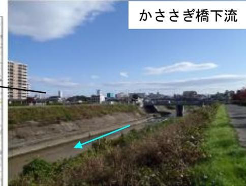
淀川合流点の直上流付近。ブロック積み護岸の複断面形状で築堤河道である。背後地は市街地である。
