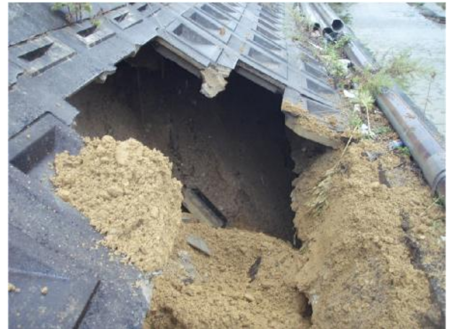
老朽化護岸(護岸の空洞化) 久保戸橋下流
