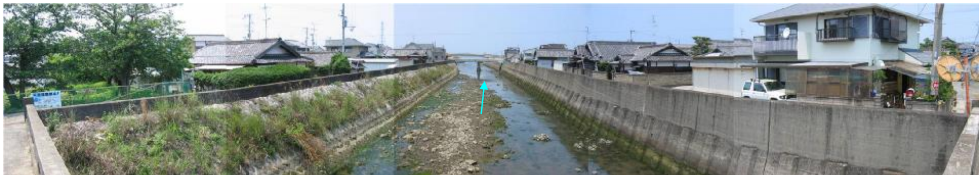
高潮区間の防潮堤(中橋下流:深日地区)
