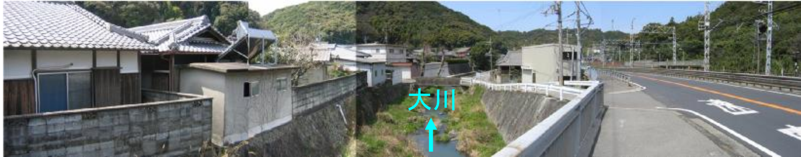
バイパスが考えられる国道26号(孝子橋付近)
