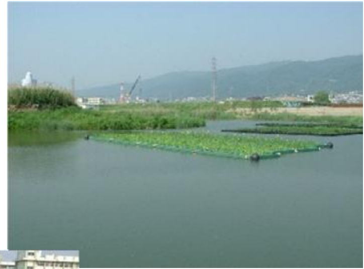
遊水地の整備 (恩智川治水緑地)
