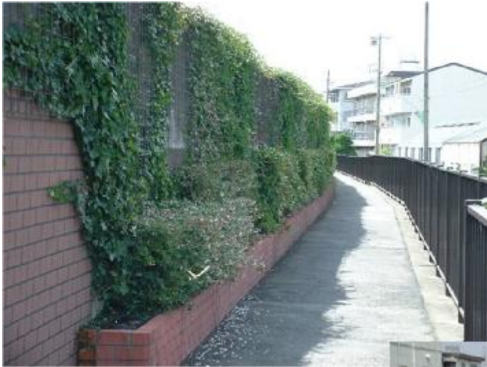
護岸の垂直緑化 (寝屋川)
