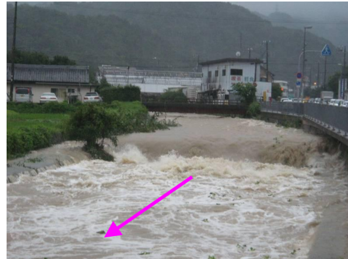
H22.7.14洪水 南海橋下流
