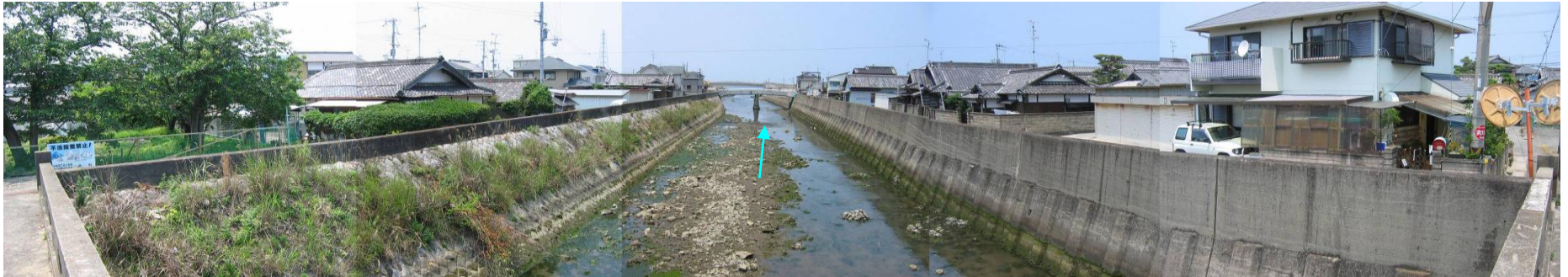
高潮区間の防潮堤(中橋下流:深日地区)
