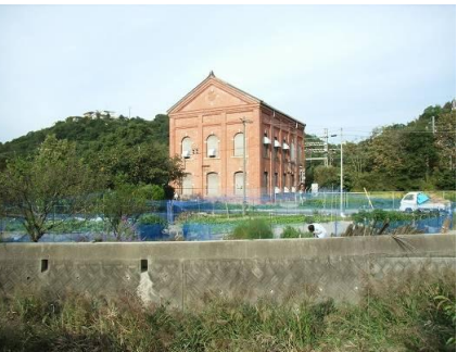
③ 南海電鉄深日変電所
