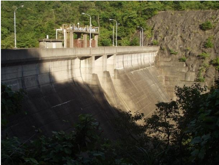
逢帰ダム堤体
