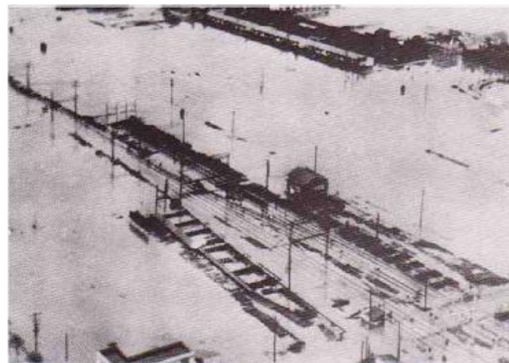
近鉄奈良線 八戸の里駅付近
