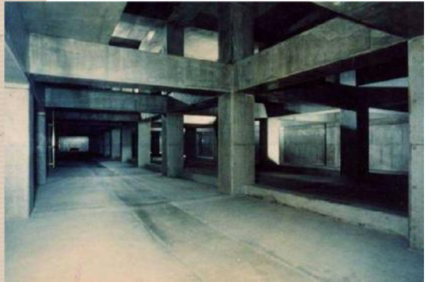
三ツ島調節池内部
