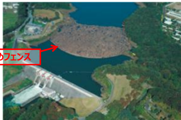
図1.4 流木止めフェンス(貯留型ダム)
