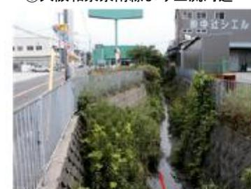
円立風高校前より上流を望む。コンクリートブロック積みによる三面張断面であるが、河幅が極端に狭くなる。河床に堆積した土砂から植生が繁殖している。
