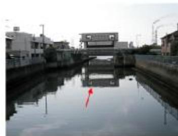
丸浪橋より河口を望む。防潮水門および直立堤による防潮堤が整備されている。コンクリート構造物による人工的な印象が強く、植生はほとんど見られない。
