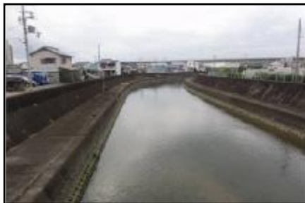
下流部の河道
