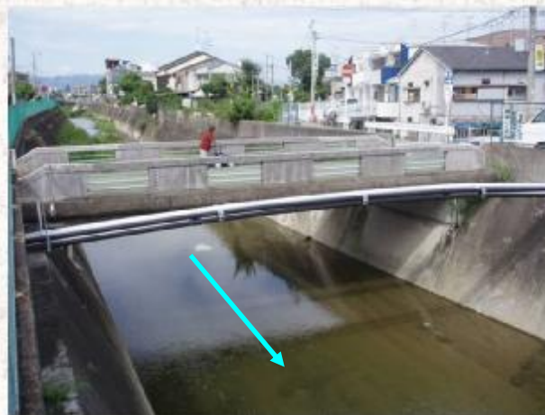
下流区間の状況
