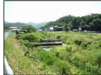
下流部の河道
