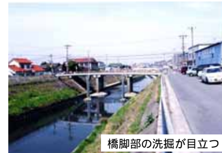
築堤およびコンクリート擁壁が見られる
