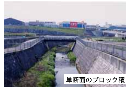
高水部がブロック積、低水部が鋼板護岸
