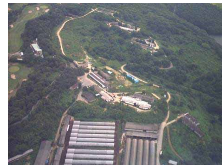
中央、上、右下の建物は牛舎や事務所など 手前の建物群は糞尿処理施設
