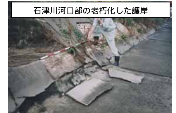
石津川河口部の老朽化した護岸
