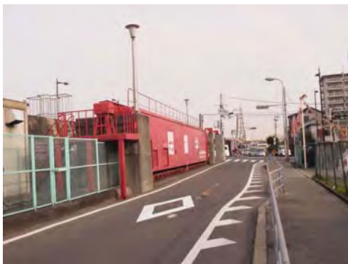
神崎大橋左岸防潮扉（国道2号鉄扉）
