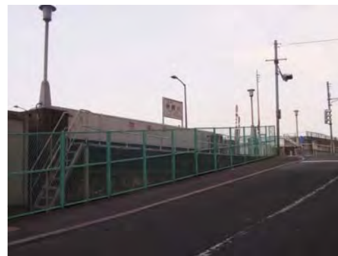
千北橋左岸防潮扉（アルミ防潮扉）
