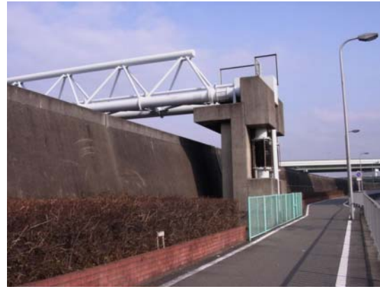
写真-2.4.2 防潮堤状況 (2)
