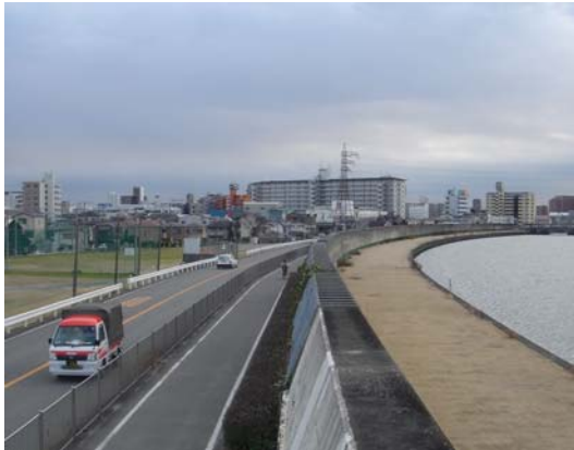
写真-2.4.1 防潮堤状況 (1)
