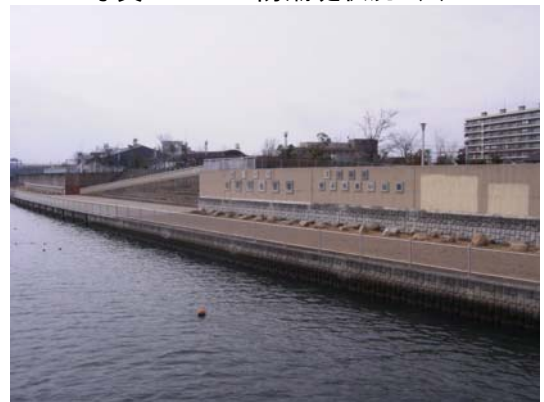
写真-2.4.4 佃防災船着場
