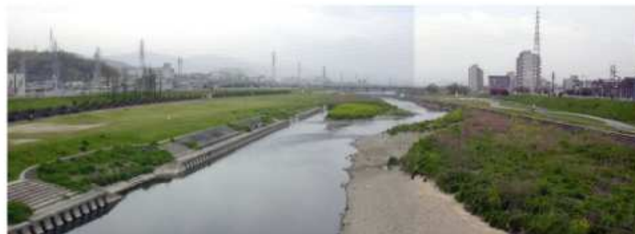
区間 A：玉手橋（上流側） No. 2
