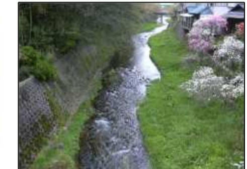
区間 C：西条橋（上流側） No. 8
