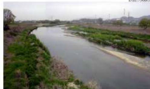
区間 A：河南橋（下流側） No. 4
