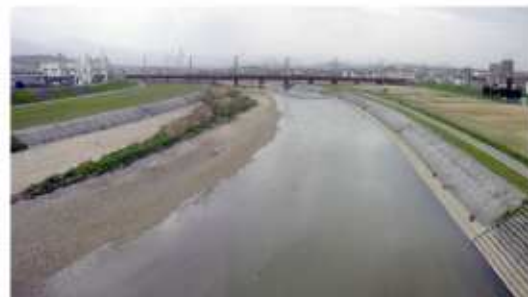
区間 A：臥龍橋（上流側） No. 3
