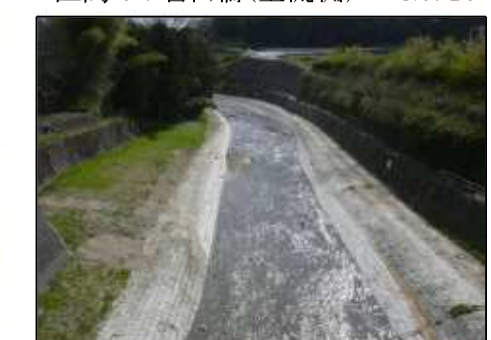
区間 C：宮山橋（上流側） No. 10
