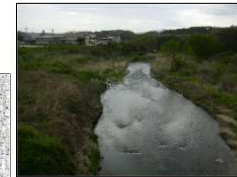
区間 B：伏見堂大橋（下流側） No. 5
