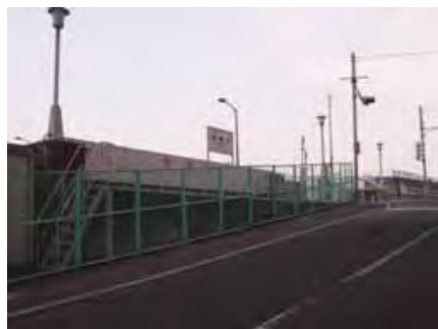
千北橋左岸防潮扉 (アルミ防潮扉)
