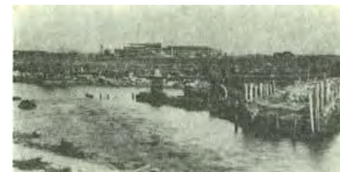
室戸台風により破壊された西島町中堤防
