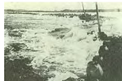
大塚の堤防決壊箇所（大正6年）
