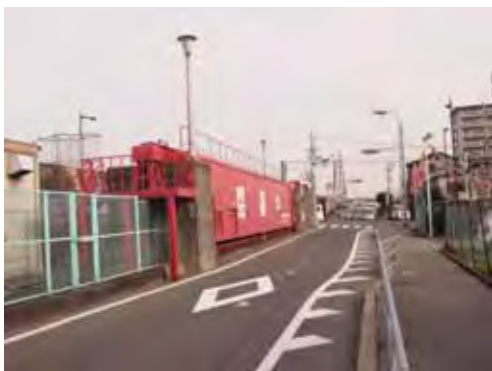
神崎大橋左岸防潮扉 (国道2号鉄扉)
