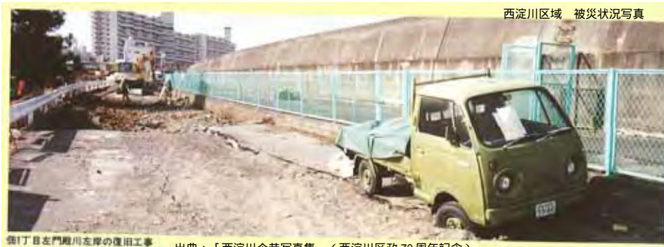
図1丁目左門川左岸の復旧工事
