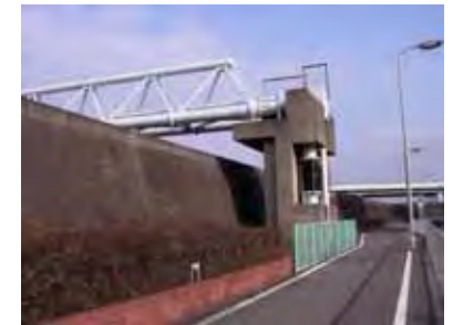
写真-2.4.2 防潮堤状況(2)
