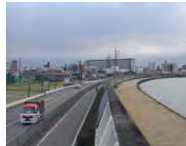
写真-2.4.1 防潮堤状況(1)
