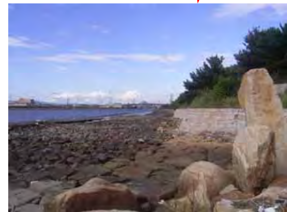
図-2.1.5 矢倉緑地（神崎川上流を望む）
