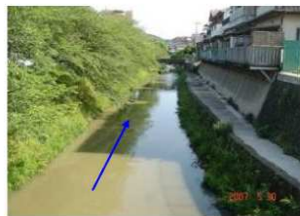
原川（府道原川橋下流付近）
