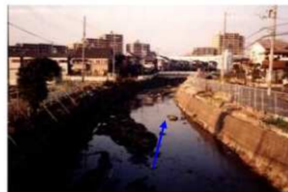
大乘川（西浦橋下流付近）
