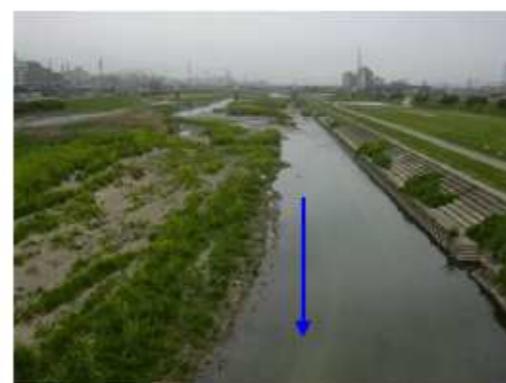
石川 (石川橋上流付近)
