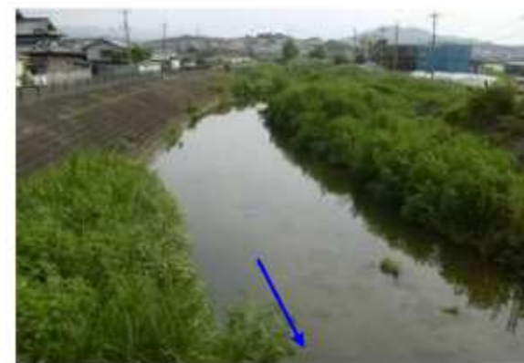
佐備川（新旭橋上流付近）
