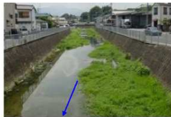
飛鳥川（逢坂橋上流付近）
