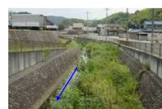
太井川（平成橋上流付近）
