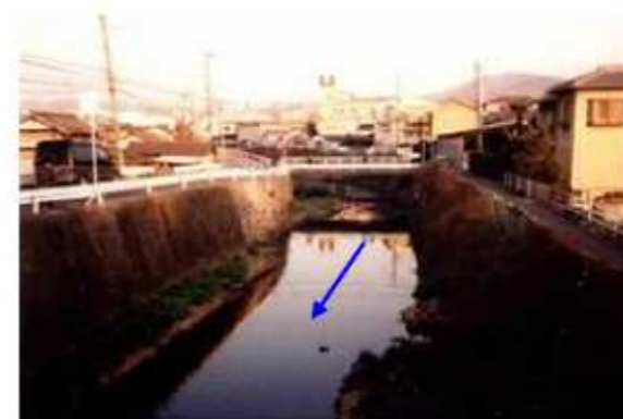
大乘川（国道166号上流付近）
