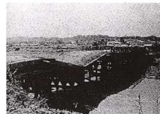
富田林市双葉（現在、西板持）付近 （昭和40年9月16～17日）
