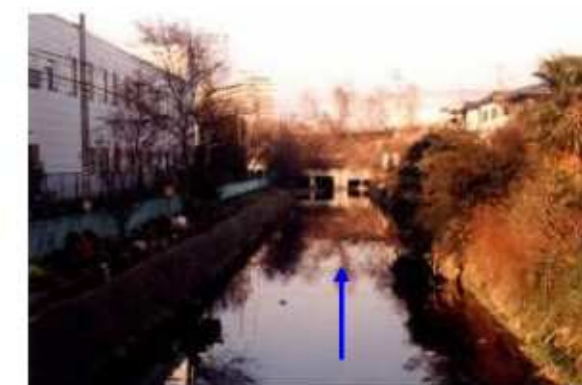
大乘川（下西浦橋下流付近）
