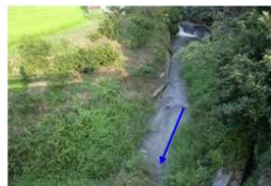
水越川（楠水橋上流付近）
