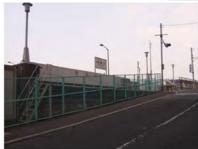
千北橋左岸防潮扉 (アルミ防潮扉)
