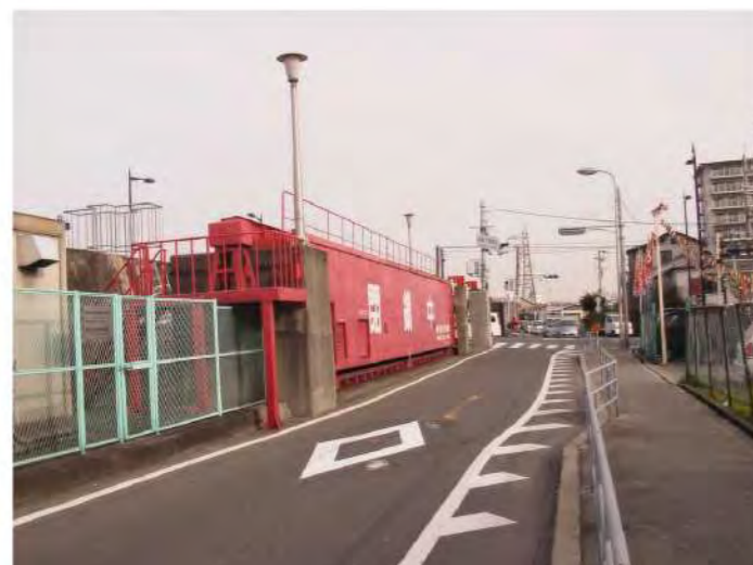
神崎大橋左岸防潮扉 (国道2号鉄扉)
