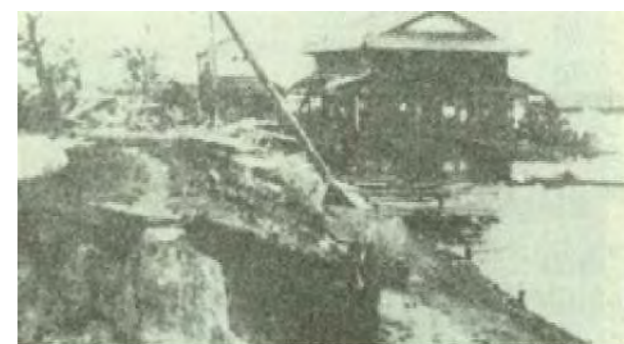
室戸台風で被災したが流出をまぬがれた民家
