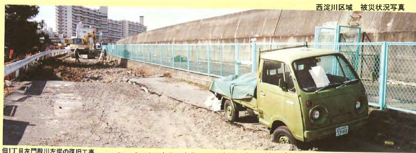
佃1丁目左門殿川左岸の復旧工事
