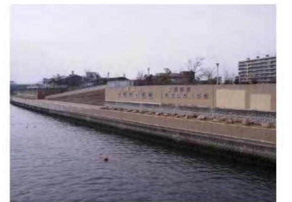
写真-2.2.4 佃防災船着場
