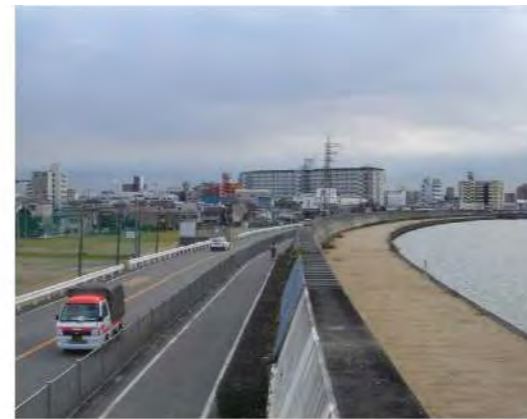
写真-2.4.1 防潮堤状況 (1)
