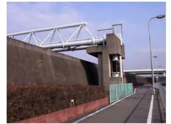
写真-2.4.2 防潮堤状況 (2)
