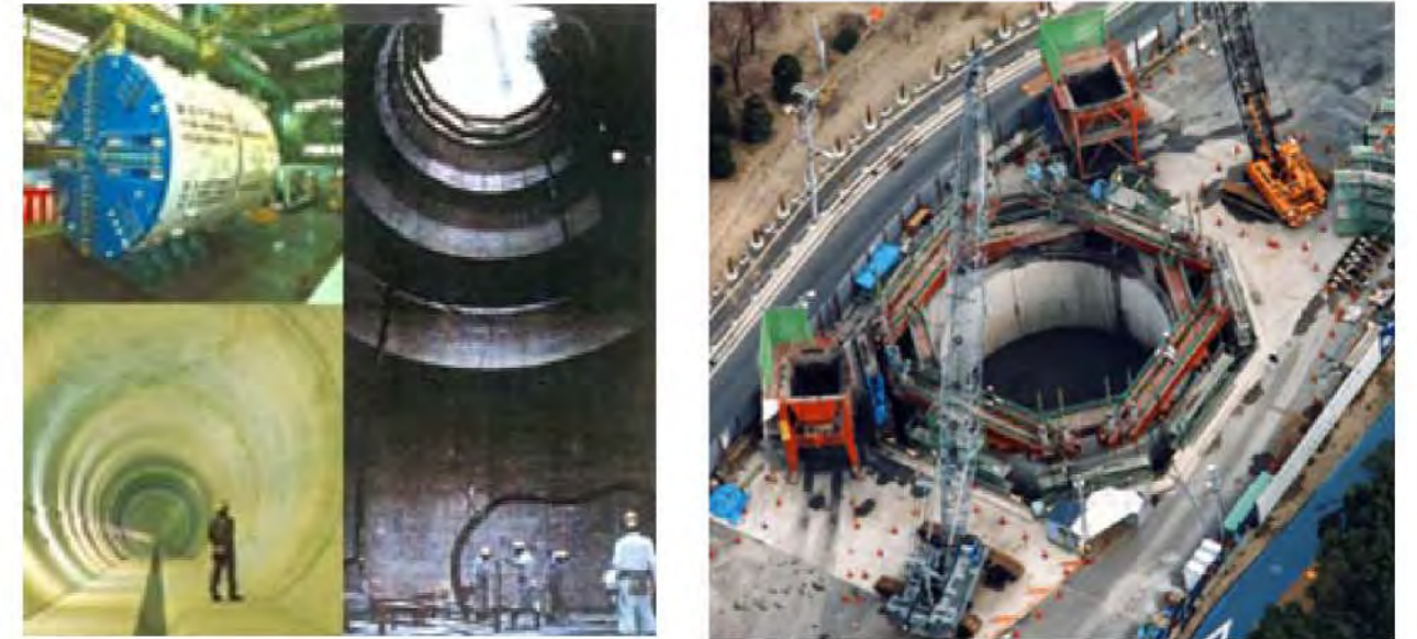
図-2.4.8 淀の大放水路の建設状況 出典：大阪市ホームページ
