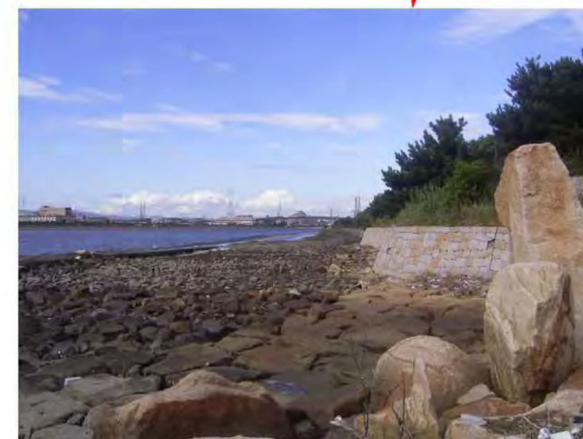
図-2.1.5 矢倉緑地（神崎川上流を望む）
