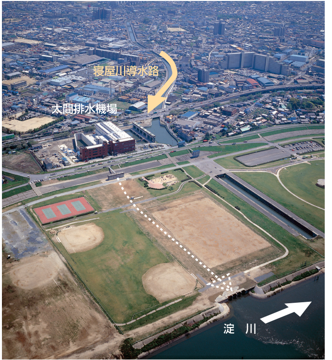
太間排水機場
