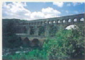
1 ガール水道橋/フランス ローマ時代につくられた、谷を隔てて水を運ぶための水道橋。
