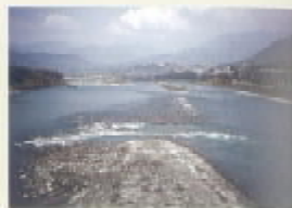
2 都江峡/中華人民共和国 紀元前256年につくられた分水施設で、現在も使われている。
