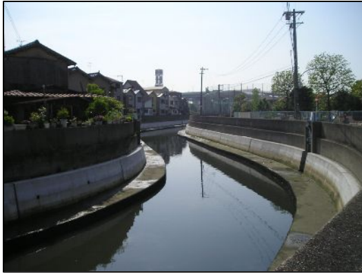
二級河川王子川（小高石橋付近）
