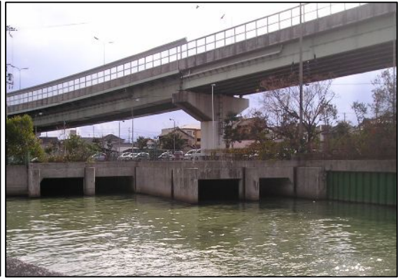
二級河川新王子川（王子川合流点）
