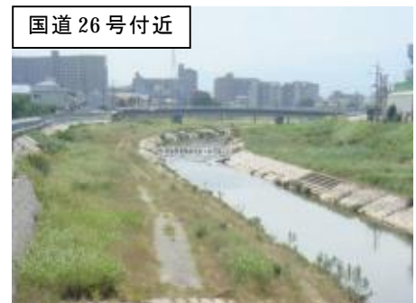
図 1.6 槇尾川（下流部）
