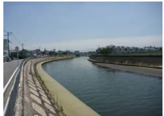
図 1.3 石津川下流部
