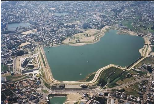
写真① 狭山池ダム全景
