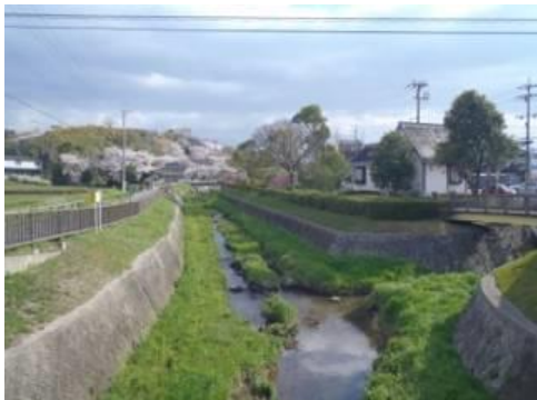
図-1.4 三津屋川の河道状況
