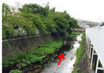
図-1.6 原川中流部の河道状況 (旭橋 あさひぼし 付近)
