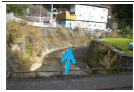
写真① 上流部(二の橋付近)
