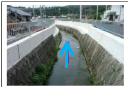
写真① 上流部（無名橋から下流）
