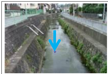
写真① 上流部(無名橋から上流)
