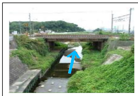
写真③ 下流部 (檜尾川橋下流付近)
