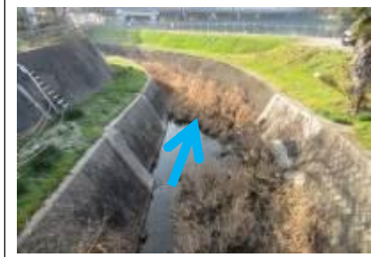
写真① 上流部（氷室橋付近）
