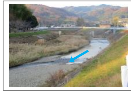
写真② 中流部（正恩寺橋下流付近）
