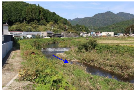
写真③ 山辺川 (柳橋 やなぎ 付近)
