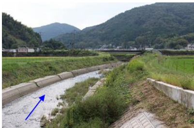
写真① 田尻川 (藤木橋付近)
