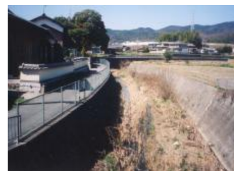
① 川合裏川 箕面市粟生間谷 川合裏川上流
