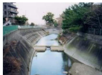
① 天竺川 豊中市豊南町 日電橋付近（天竺川）
