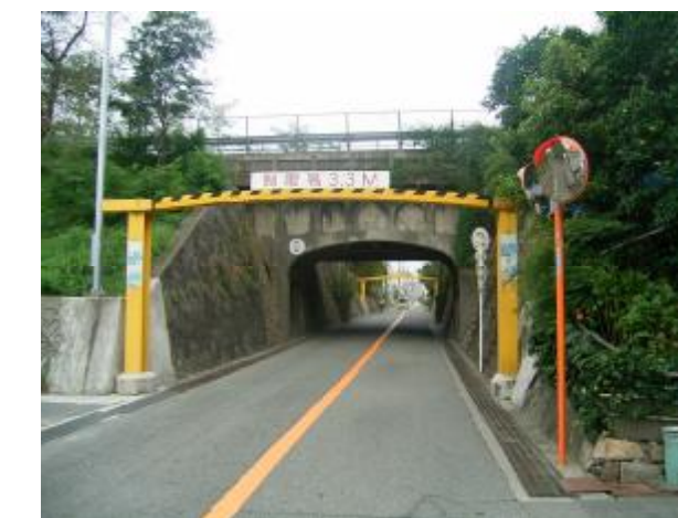
高川 吹田市江坂町 水路橋
