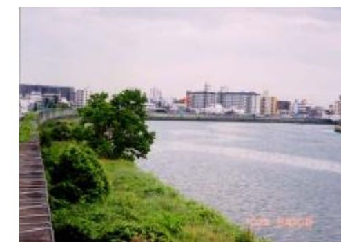
② 神崎川 西淀川区御幣島 神崎大橋上流
