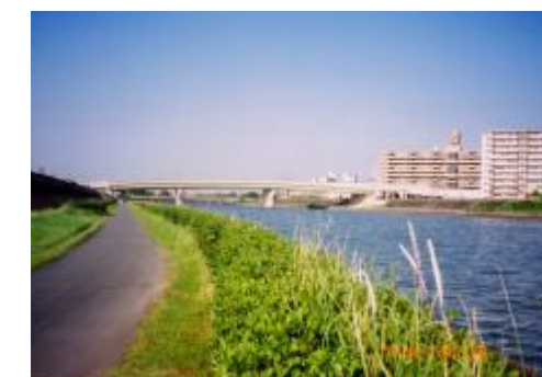
④ 神崎川 東淀川区西淡路 新大吹橋下流
