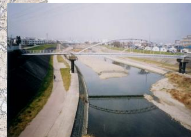
③ 安威川 茨木市床 千歳橋上流点
