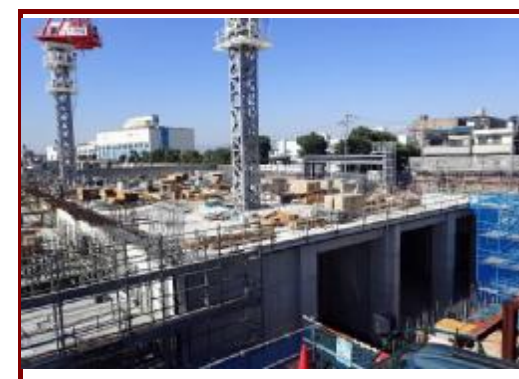
写真④ 沈砂池棟北BL(1F床迄完了)
