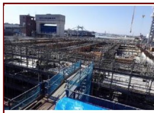
写真③ 沈砂池棟南BL(B1F壁上部施工中)
