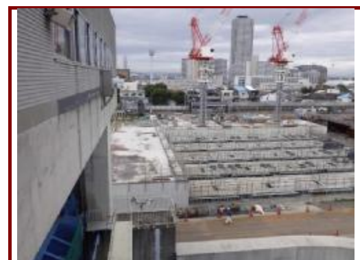
写真② 放流渠躯体(完成)
