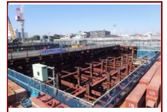
写真⑥ ポンプ棟Ⅱ期(B3F壁 施工中)
