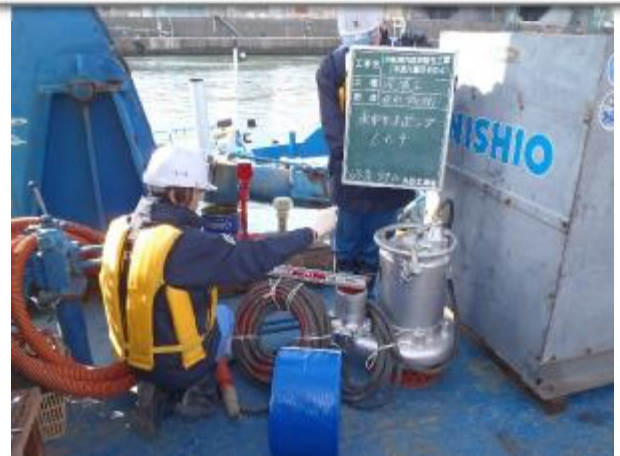
( 水 中 サ ン ド ポ ン プ 機 械 確 認 状 況 )
