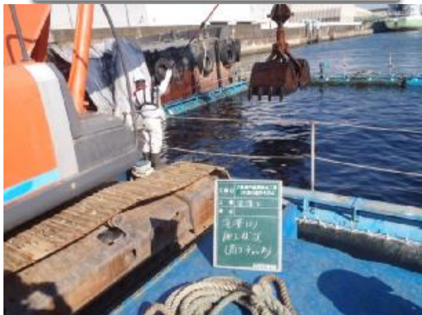
( グラブ 浚 渫 状 況 )
