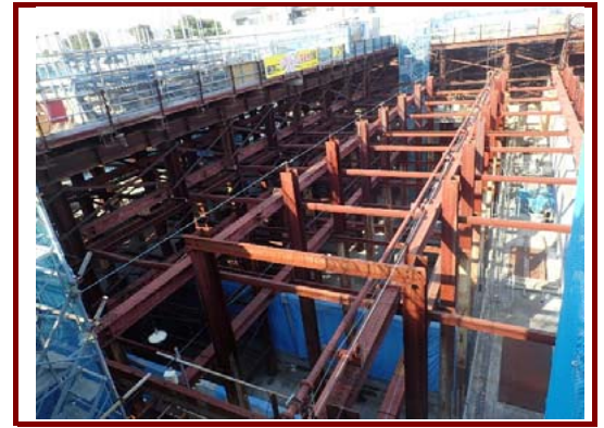
写真⑥ ポンプ棟Ⅱ期(B3F壁 施工中)
