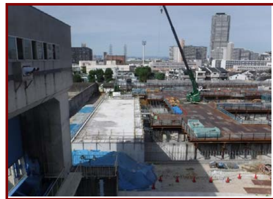
写真② 放流渠躯体(完成)
