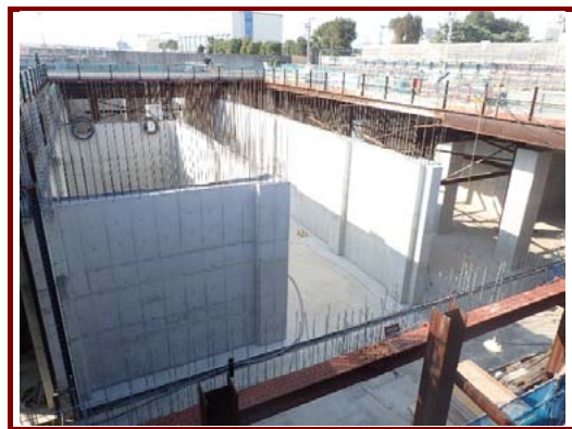
写真④ 沈砂池棟北BL(B1F壁迄完了)
