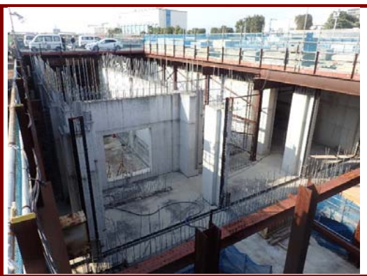
写真③ 沈砂池棟南BL(B1F壁迄完了)
