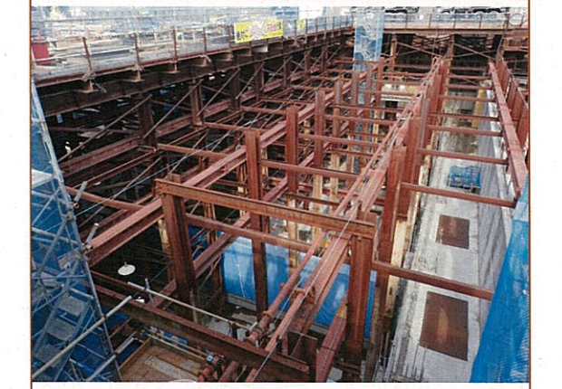
写真⑥-ポンプ棟Ⅱ期 (B4F壁 打設状況)
