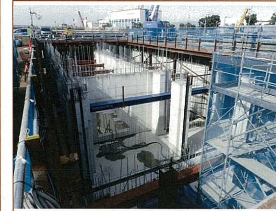
写真④-沈砂池棟南 BL (B1F 迄完了)
