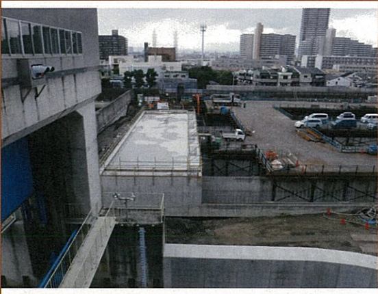
写真②-放流渠躯体 (完成)
