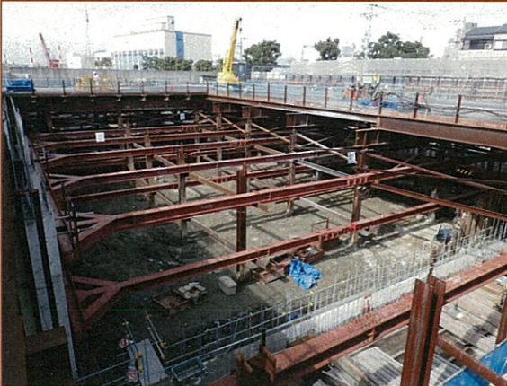
写真③-沈砂池棟北 BL (2 段目土留支保工架設)
