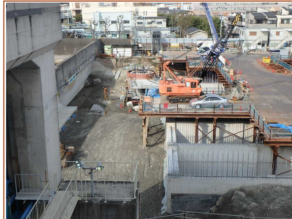
写真③—立坑工（現況）
