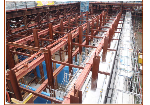
写真⑤—ポンプ棟Ⅰ期（B1F床版、仮壁打設完了）
