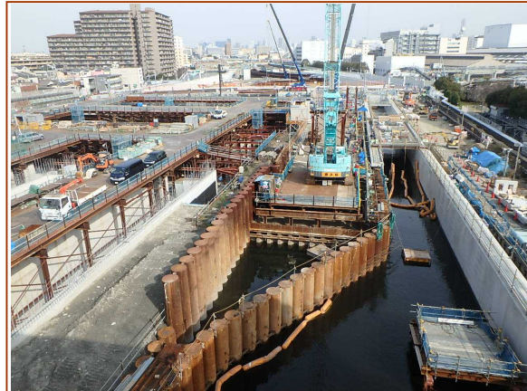
写真②（水路面）
