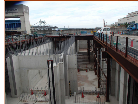
写真④—沈砂池棟（B1F）
