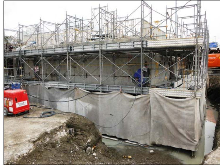
③ 転流立坑撤去工
