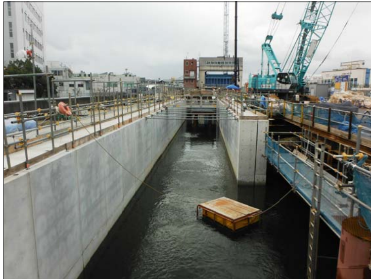
① 最下流部整備工事
