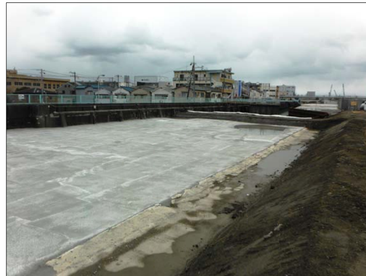
④ 仮水路埋土工
