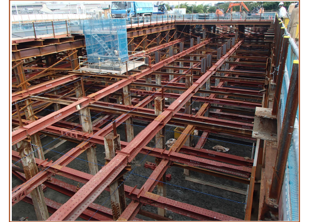
写真⑥—ポンプ棟Ⅱ期（仮設工）
