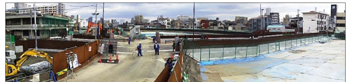
千鳥橋 ⑬ 下流より
