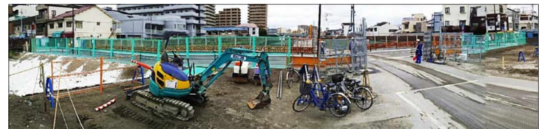
恩貴島橋 ⑦ 下流より
