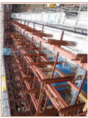
写真⑤ - ポンプ棟Ⅰ期 (B1F床版、仮設打設完了)
