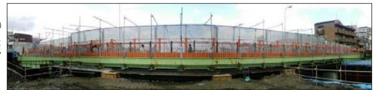
恩貴島橋 ⑦ 上流より
