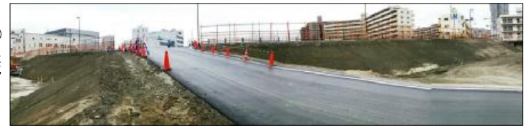
北港新橋 ⑤ 上流より
