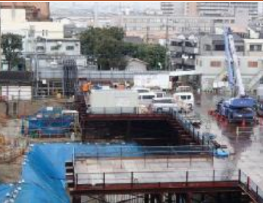
写真③—立坑工（現況）
