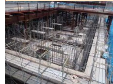
写真④—沈砂池棟（B1F）
