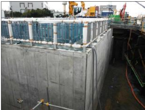
② 最下流立坑部
