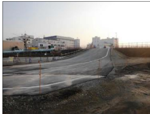
⑤' 北港新橋上流より
