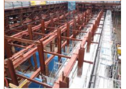
写真⑥—ポンプ棟Ⅱ期（仮設工）
