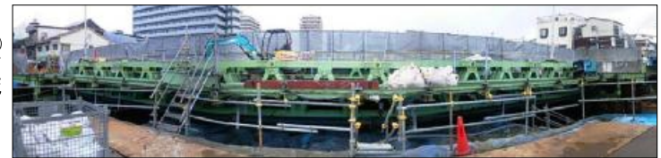
恩貴島橋 ⑥ 下流より
