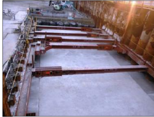
③ 河川ボックス施工状況
