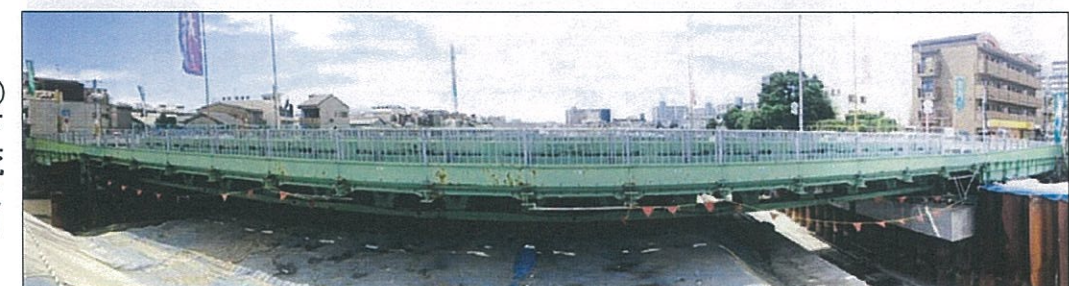
恩貴島橋 ⑦ 下流より
