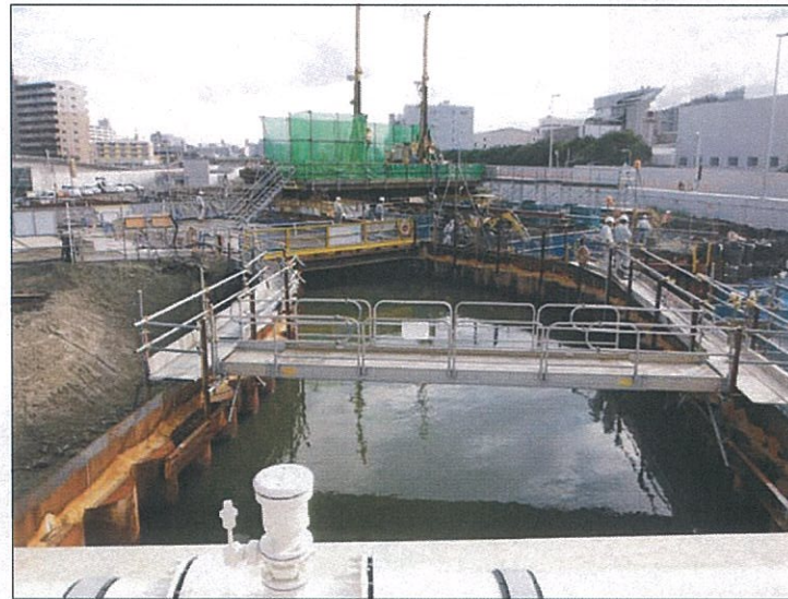
③ 北港大橋より上流を望む
