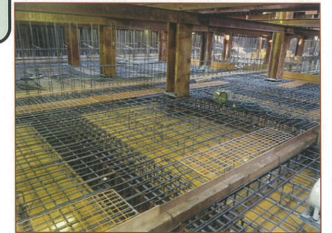
写真④B2F スラブ 鉄筋組立完了
