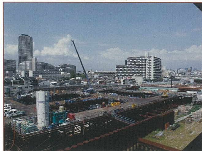
写真①（水門側から）
