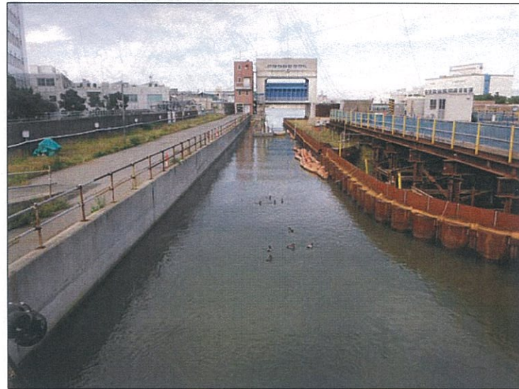
① 最下流部整備工事
