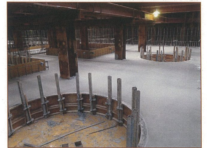
写真④B2F スラブ Con 打設完了
