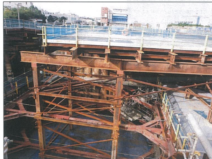
② 最下流立坑部
