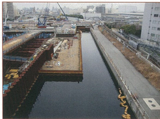
写真②（水路面）
