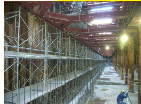
写真④B3F 壁鉄筋組立
