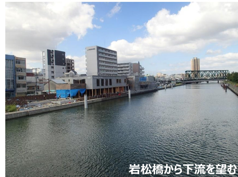
施工状況（令和元年9月17日）
