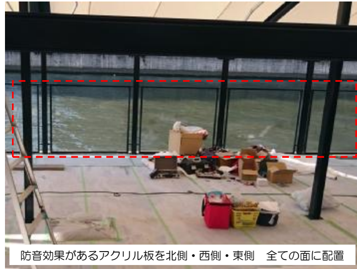
台船×鉄骨×オールで構成された水上空間
