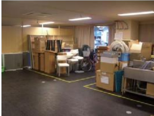
△ 間仕切設置前（資材乱雑）
