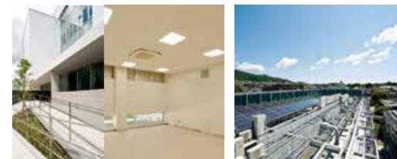
デザインされた外気採入口 (左) より取り入れた空気を、地中熱によって冷却し共用スペース (右壁上部吹出口) に供給 / 雨水回収槽 (右写真下部) の設置により、雨水を植栽の自動灌水やボイラールーム水の冷却に活用
