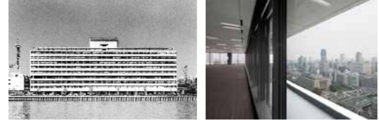
旧・新ダイビルの外観。永く親しまれた横基調の外観を踏襲 深い庇で日射から守られたフルハイトの窓から、中之島・御堂筋をプラインドレスで俯瞰する。
