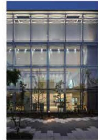
ダブルスキン内の温度及び外気温度と比較し、夏季は高温になったダブルスキン内の空気を屋外へ排出、冬季は暖められた空気を室内に導入する。
