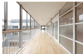
中庭からの自然光を教室に取り込むガラスのスクリーン
