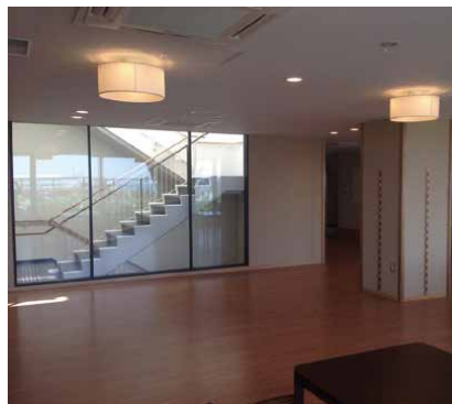
階段に窓を設置し、自然採光を室内に取り込み
