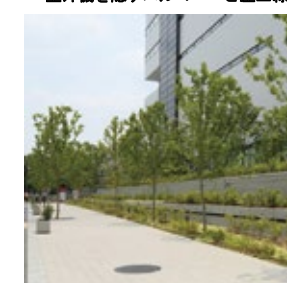
拡幅された並木通りと建物上部の緑地帯
