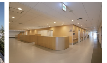
【2】スケジュール制御された共用部照明
